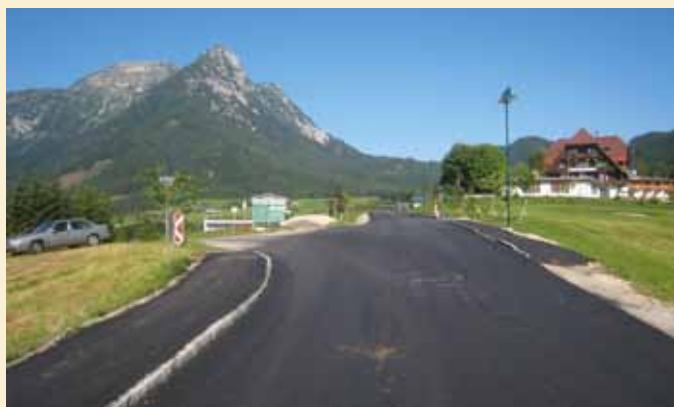
Neue Asphaltierung der Sommersbergseestraße mit Gehsteig.
