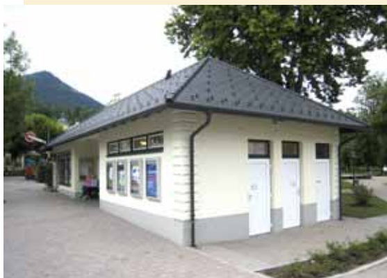
Neues Kurparkgebäude in zentraler Lage mit öffentlichen WCs und vermietetem Geschäftsbereich.
