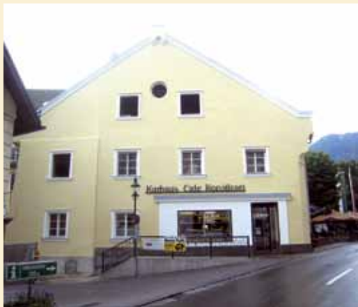
Fünf neue Wohnungen im Dachbodenbereich des Kurhauses erfreuen sich wegen der zentrale Lage großer Beliebtheit.
