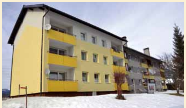
Sanierung Gemeindewohnungen in Eselsbach.
