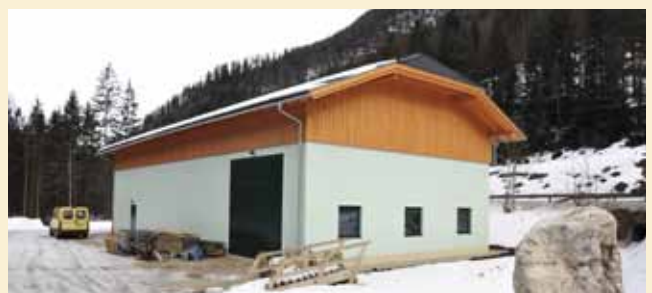
Neues Kraftwerk der ÖBf an der Ödenseer-Traun.
