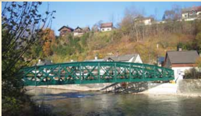
Die alte Beck-Brücke wurde generalsaniert und auf neuem Standort als Zubringer zur Bahnhofpromenade (damit erstmals mit mehrspurigen Fahrzeugen erreichbar!) wieder errichtet.
