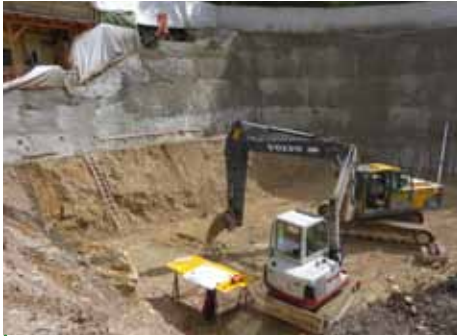
Aushub und Befestigung des Untergrundes, Betonierung der Bodenplatte
