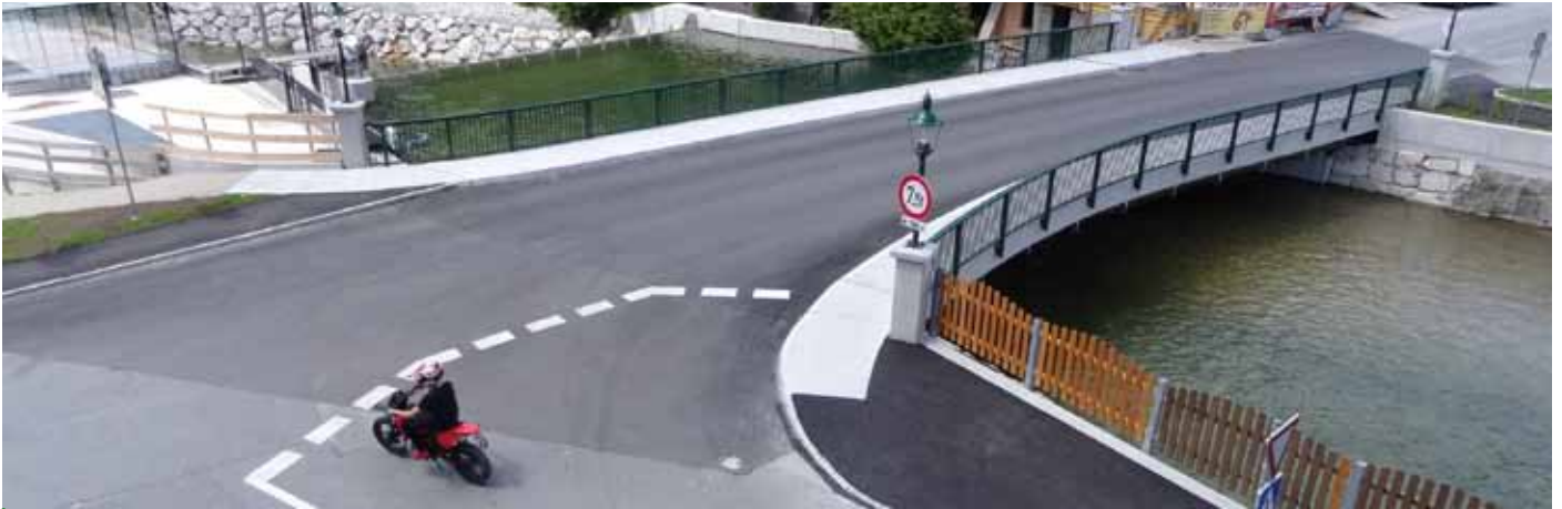
Die neue Reiterer Brücke trägt mit ihrer Ausrundung in Richtung Altausseer Straße und den beidseitigen Gehsteigen wesentlich zur Erhöhung der Verkehrssicherheit im Stadtzentrum von Bad Aussee bei.
