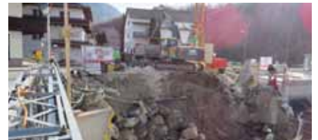
Abbruch der alten Brücke
