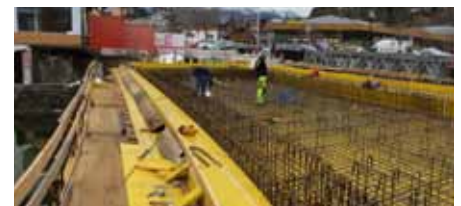
Schalungsarbeiten an der neuen Brücke
