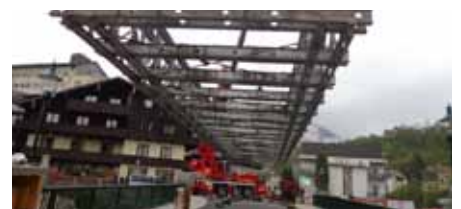
Demontage der Behelfsbrücke
